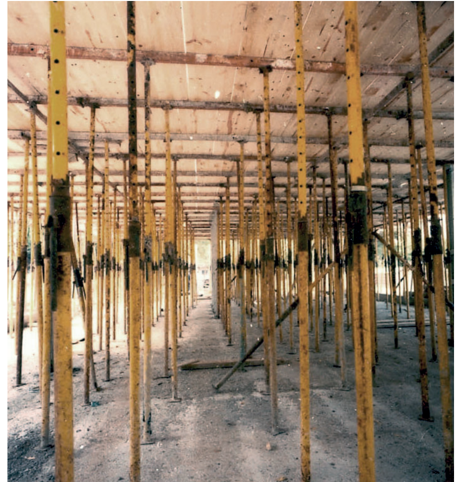
Apuntament de l'encofrat de la llosa de coberta, 1986. Fotografia: Francesc Català-Roca
