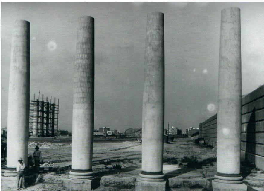
Plaça de Belles Arts: construcció de columnes model, 1919. Font: Montjuïc 1915. Primera mirada
